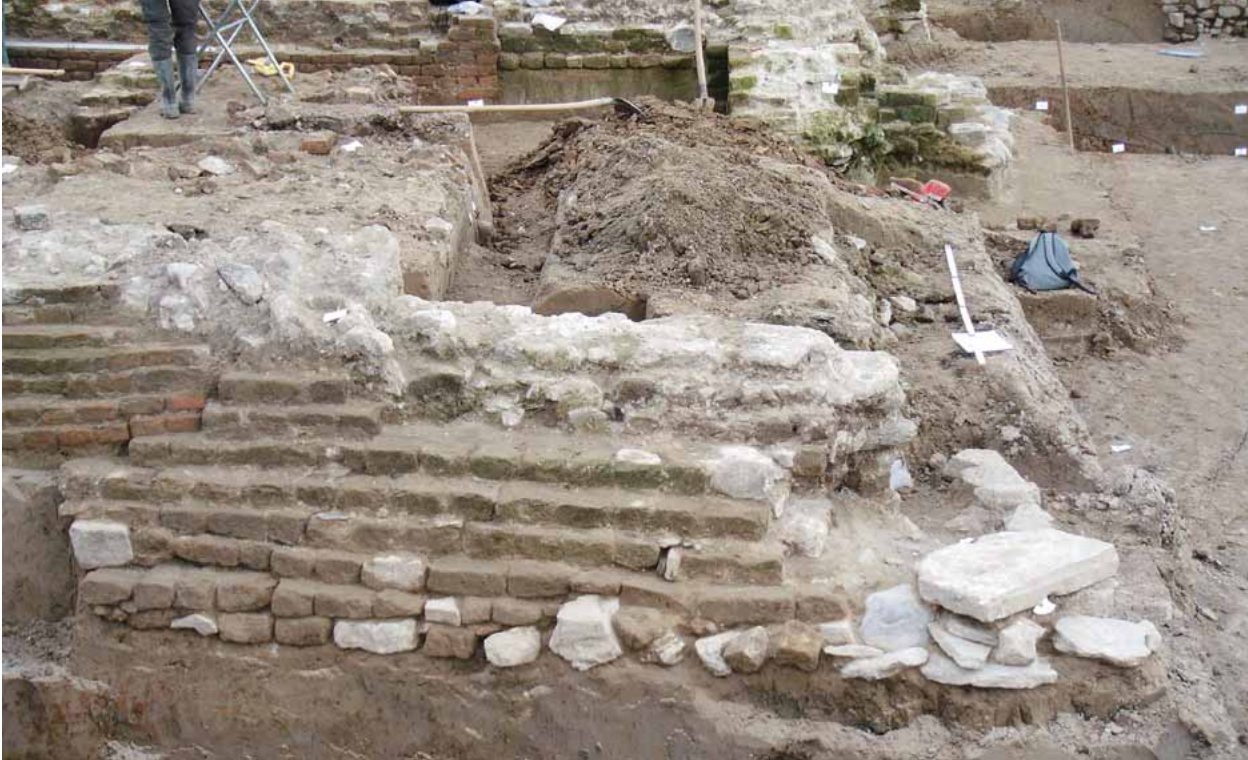
Figuur 10.7. Bekisting in beeld. Op de voorgrond tufsteen (bruin) met daarin een witte opvulling. Links baksteenverband (rood), rechts op de hoek de witte kalkstenen bouwinscriptie. Uiterste zuidwesthoek van het kasteel Lent (zone O2). MK
